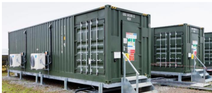
Billede 7: Eksempler på hhv. 20- og 40-fods container batterianlæg. Kilde: (fra venstre) KonkaEnergy og Anesco.
