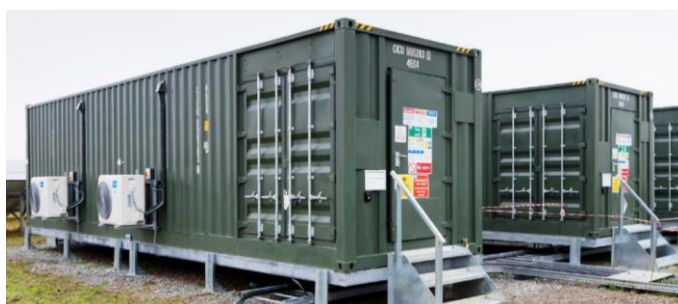
Billede 7: Eksempler på hhv. 20- og 40-fods container batterianlæg.
